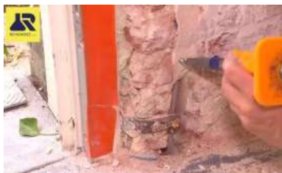
Verwijderen pleisterwerk rond leidingen
